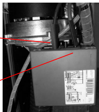
Elettrodi accensione/rilevazione
